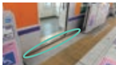
ホーム先端部の改修
