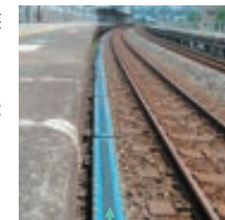
転落支障報知装置（マットスイッチ）
