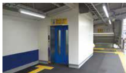
△エレベーター
