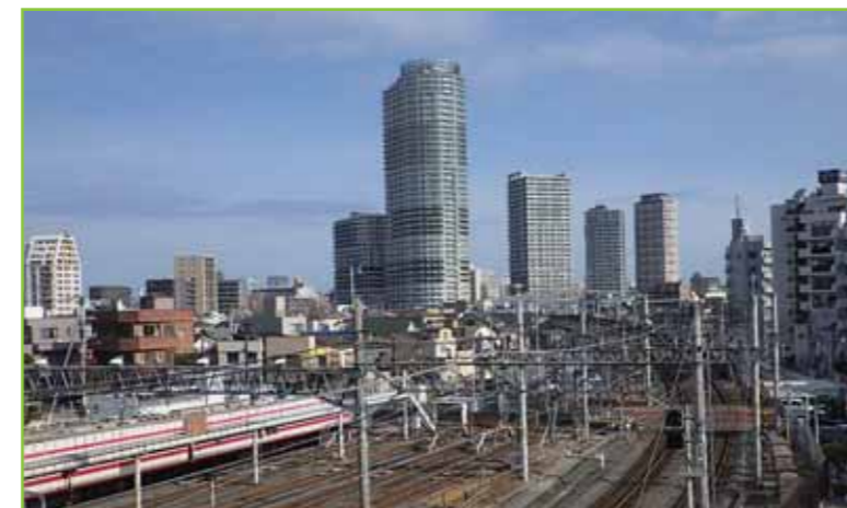
～当面の工事予定～ 主に留置線の一部移設・撤去、支障物の移設・撤去を行うほかⅠ工区において地下躯体の補強を行う予定です。
