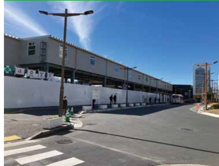
南北連絡通路外観
