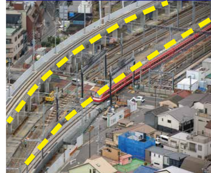
2023年2月(下り線工事着手時)
