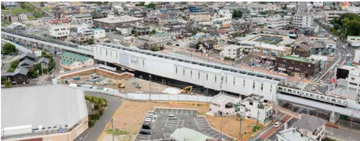
高架化した愛宕駅付近の様子
