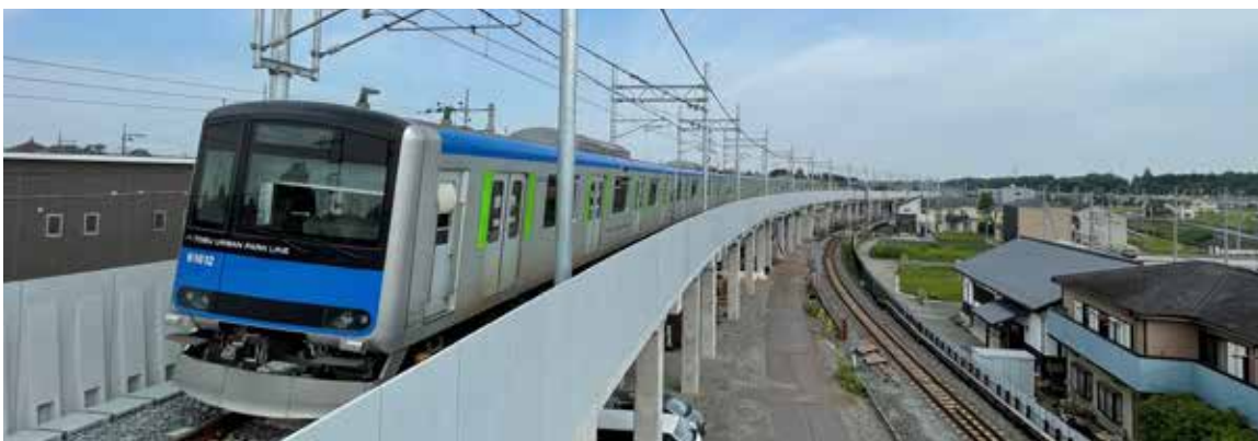
愛宕駅付近の高架橋
